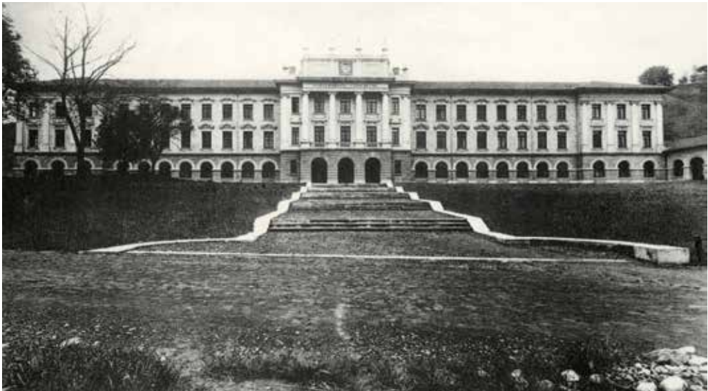
El edificio de la Comercial, prácticamente terminado. El arquitecto José M a Basterra al describirlo, certificó que ocupaba una extensión de 3.679, 90 metros cuadrados, ascendiendo su coste a dos millones setecientas mil quinientas veinticinco pesetas, con diecisiete céntimos.
